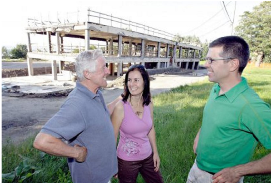
Paul-Henry April, Valérie Jamin et Michel Desgagnés, sont réunis devant la carcasse d'un immeuble qui, à terme, sera l'ossature de 18 des 40 logements sur la rue Louis-Jetté dans le quartier Saint-Sacrement. Le Soleil, Pascal Rathé
